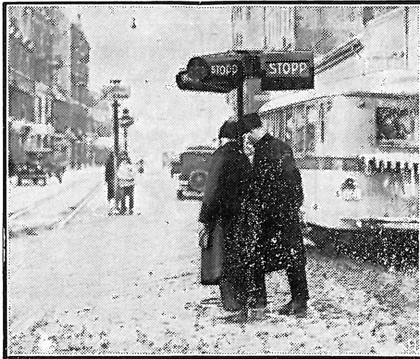
Det nye signalapparat på Brogate-hjørnet.
