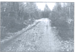
Ormåsen. Veien er rustet opp med tungmetallholdige masser.
